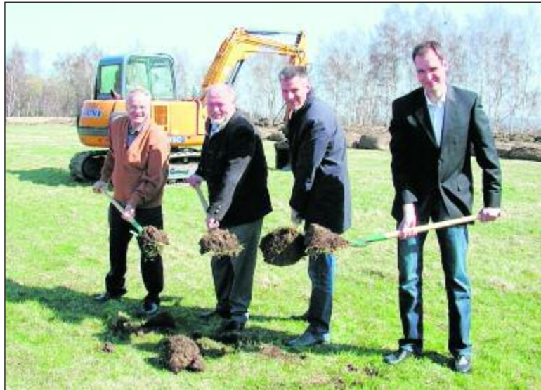
Spatenstich für den Sportplatz am Schachtweg: der ehemalige Objektleiter Peter Haupt, Landrat Volker Uhlig, BSZ-Schulleiter Frank Wehrmeister und Sportlehrer Fabrice Anke (v. l.) legten Hand an.
