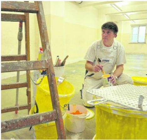
Peter Liebscher von der Malerfirma Lorenz aus Brand-Erbisdorf mischt gerade die Farbe für Räume im Haus 1 an. FOTO: ECKARDT MILDNER
